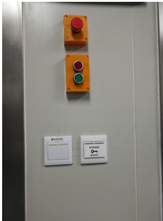
控制室小铅门外开关按钮、紧急停机开关
