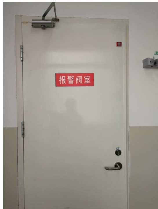
DSA 机房南侧报警阀室门外
