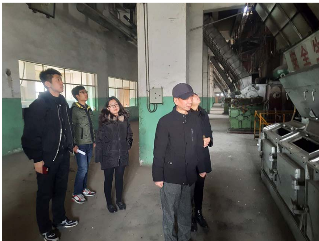
图 3-停用的燃煤锅炉现场
